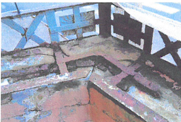
Skorodowany płotek osłonowy.
