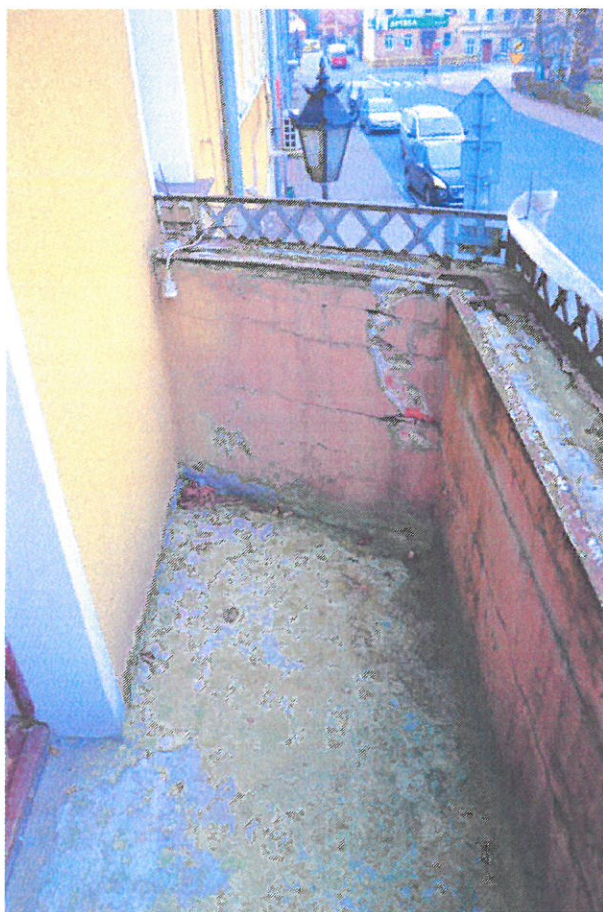
Podłoże betonowe po skuciu posadzki z lastriko.
