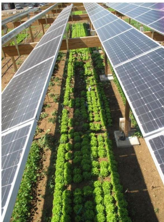
Fotografia 7 Przykład zainstalowanej elektrowni fotowoltaicznej na gruncie, który jest nadal użytkowany rolniczo
