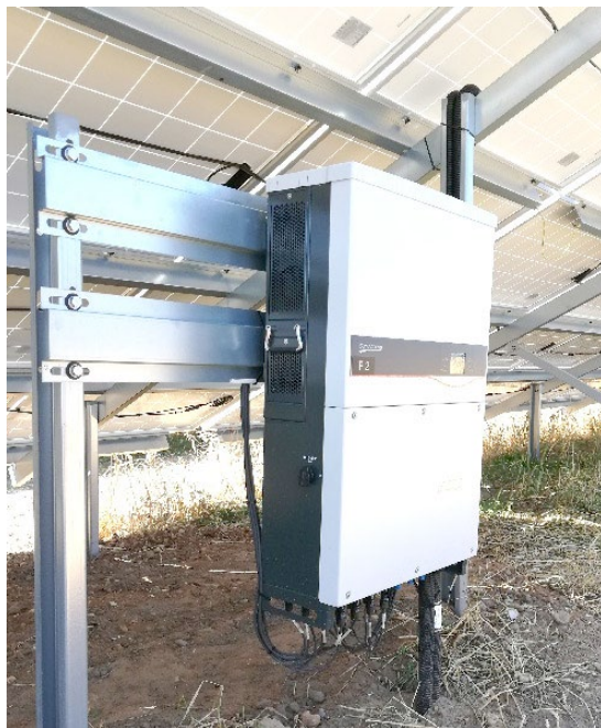
Fotografia 2 Przykładowy inwerter zlokalizowany pod panelami fotowoltaicznymi
