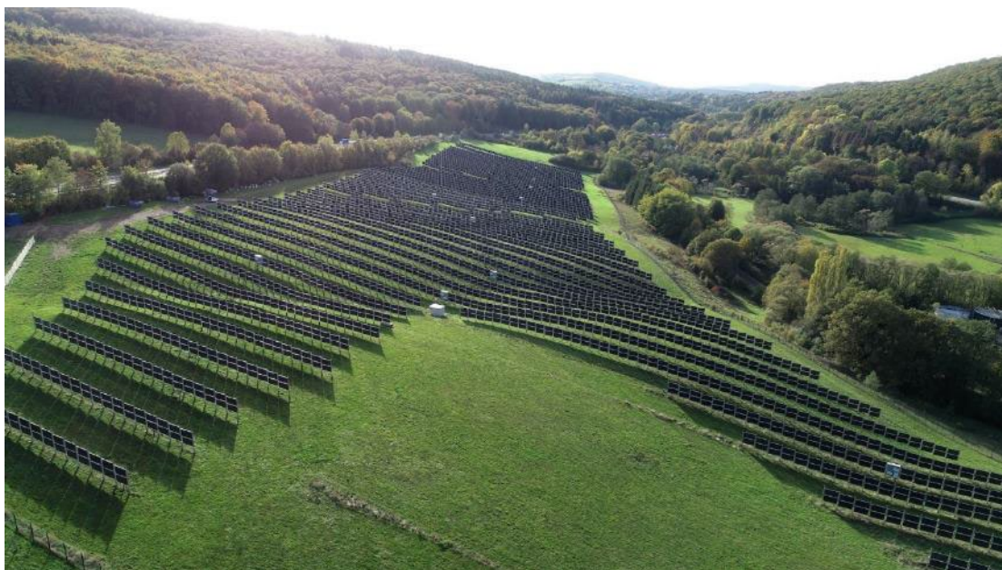
Fotografia 8 Panele w układzie wschód zachód, ustawiane w pionie (źródło: https://www.next2sun.de dostęp z dnia 29.05.2020 r.)
