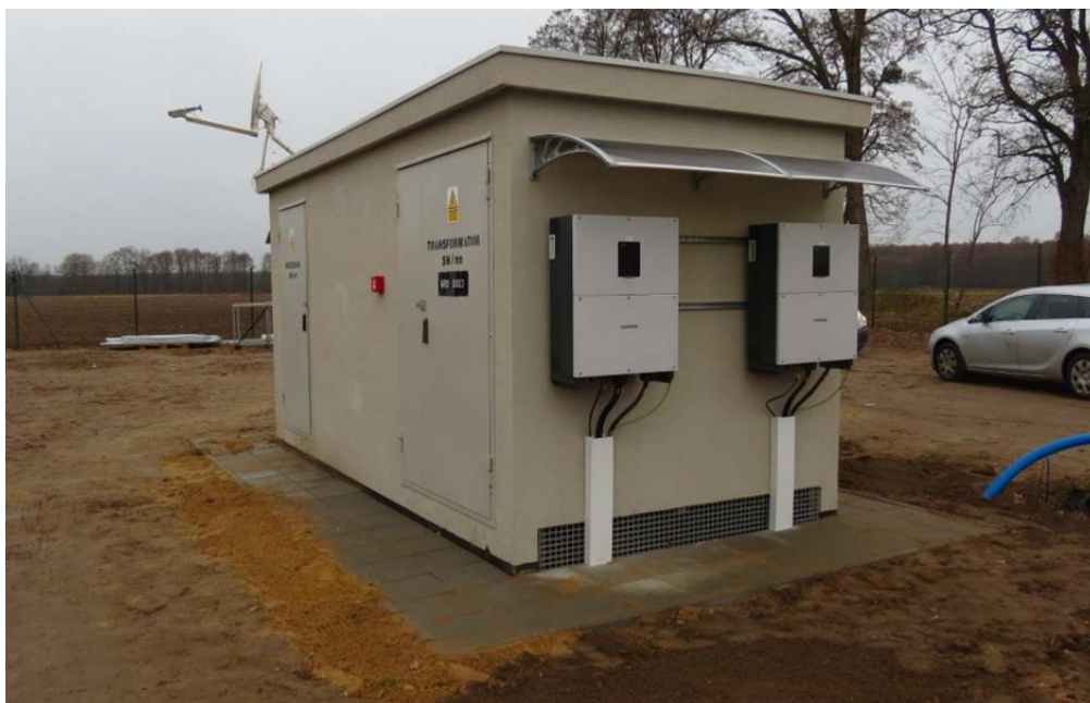
Rys. 14 Przykładowa stacja transformatorowa z zainstalowanymi inwerterami
